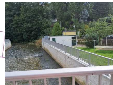
Blick von der Brücke Hedwigstraße nach unterstrom
