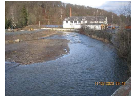
Bereich der Gewässeraufweitung
