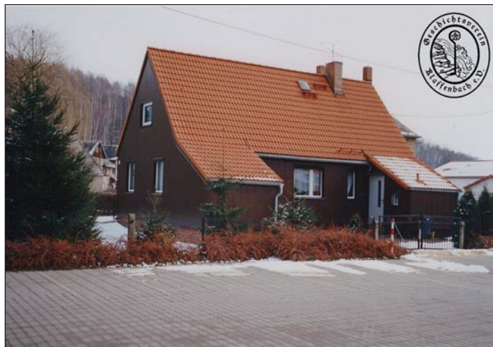
1994 wurde das alte Haus von Familie Reichelt umgebaut und modernisiert.
