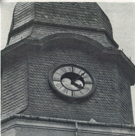
Foto: GHK KL-2903: Nach der Orkannacht am 28. Januar - Sicht vom Friedhof zum Turm. Die zerbrochene Scheibe hängt noch an der Kardanwelle der Zeiger.
