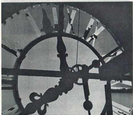
Foto: JHK-52018: Blick aus dem Turm durch das kaputte Zifferblatt. Das Zeigerpaar ist ausgekoppelt und zeigt ständig auf um 4 Uhr.
