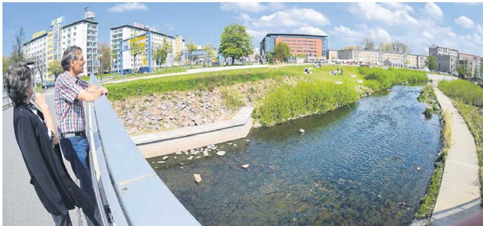
Wenn die Würschnitz und die Zwönitz Hochwasser führen, drohen auch der Innenstadt Überflutungen durch den Chemnitz-Fluss. Besonders gefährdet ist dann der Bereich am Falkeplatz (Foto). 1954, 2002 und auch 2013 gab es Überschwemmungen in diesem Bereich.
