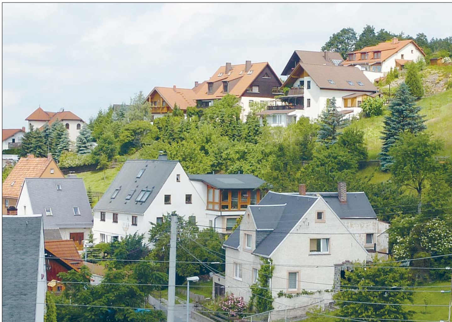
An der Hauptstraße, unterhalb des Steinbruchs, bis hoch zur Buswendeschleife, wurden einige Lücken mit weiteren 10 Häusern geschlossen
