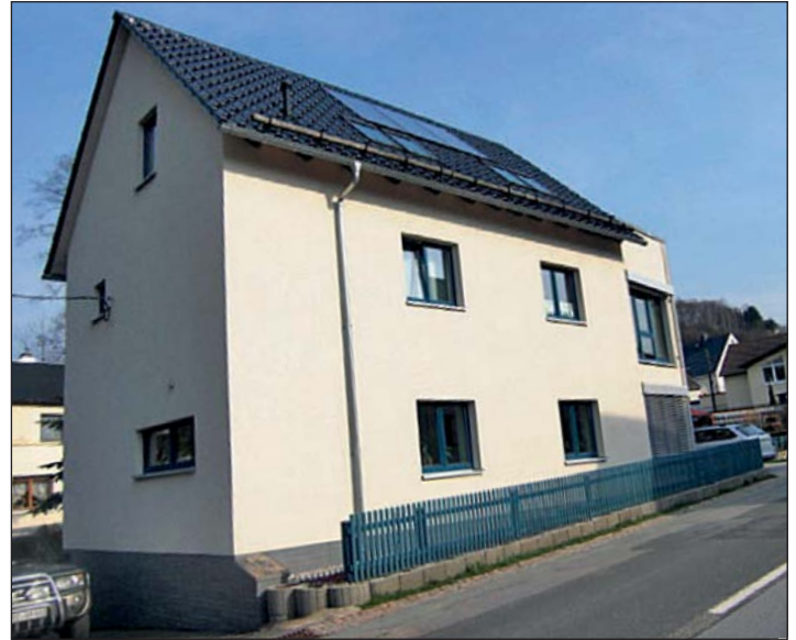
1994 wurde das Haus von Frau Reinhold erworben. 1998/99 befand sich darin die Fahrschule Stümpel. 2010 erfolgte Um- und Anbau von Familie Reinhold, Richtfest war im September 2010 und Einzug bereits im Dezember 2010. Die Grundmauern sind komplett stehengeblieben.
