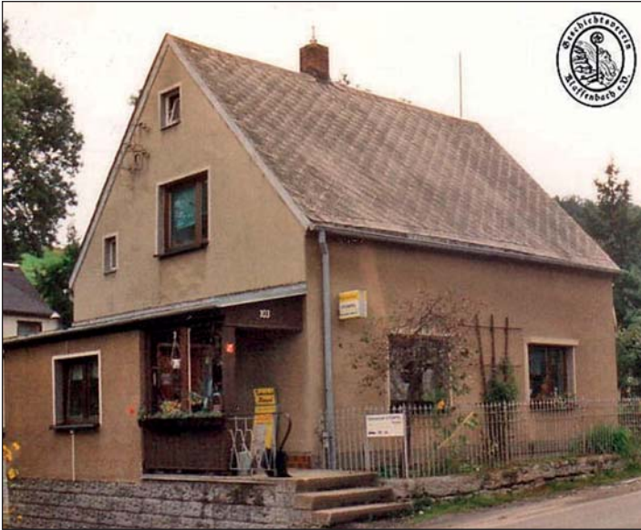
Dieses Haus steht in der Ortsmitte etwas oberhalb der Gemeinde. Es ist das Landgraf-Haus auf der Klaffenbacher Hauptstraße 103.
